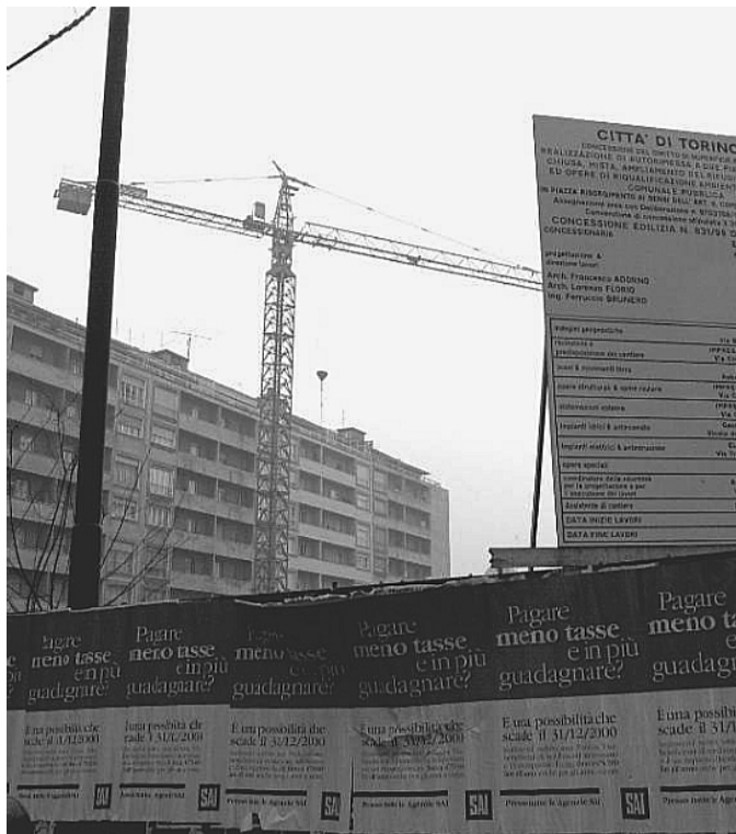
POSTI AUTO Il cantiere per il parcheggio di via Fabrizi [FOTO: RAMELLA]
